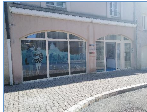
Antenne à Dole
