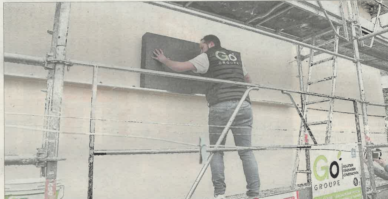
Le premier Bâtiment basse consommation (BBC) solidaire a été lancé à Lons-le-Saunier. Photo Progrès/Philippe TRIAS
