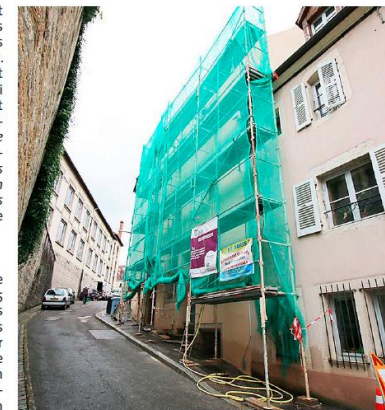
Rénovation de façade rue Pointelin, opération pour laquelle les propriétaires peuvent solliciter une participation au titre de l'OPAH-RU.
