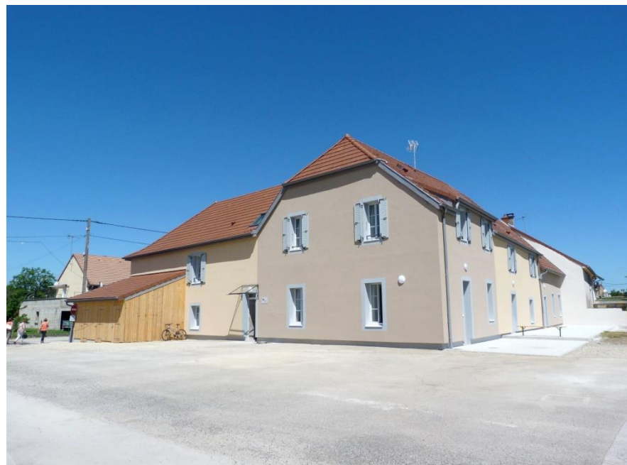
Courlaoux : Résidence Les Lilas (6 logements BBC)
