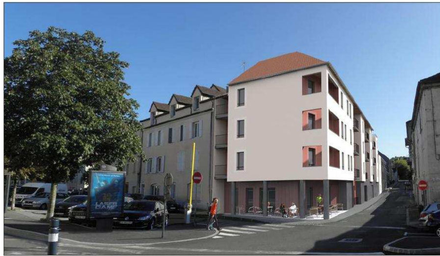
■ La résidence des Tanneurs à Lons-le-Saunier a fait l'objet d'une démolition puis d'une reconstruction. Photo archives DR
