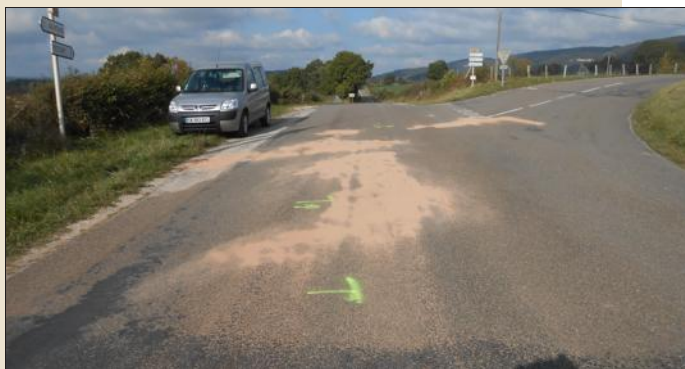
■ Un petit dos-d'âne s'est formé sur cette portion de route. Photo Louis PAGET
