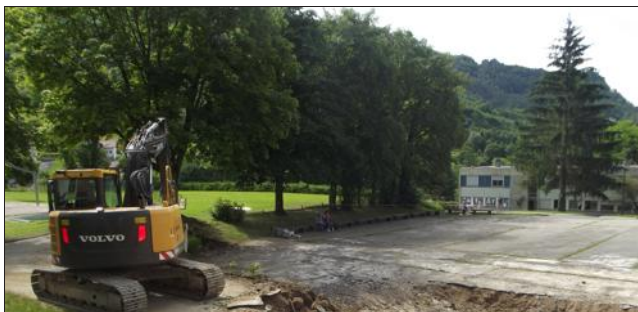
■ Dès mardi 5 juillet, les engins étaient en place. Photo Philippe MEULLE
